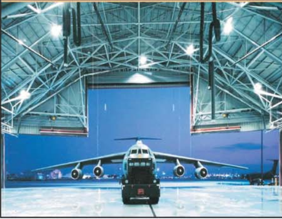
Hangar Uygulaması: Düz Tip Çok Yakıclı Sistem-Genel Isıtma
