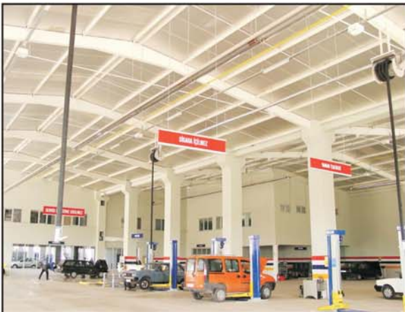
Servis Uygulaması: Düz Tip Üniter Sistem-Genel Isıtma
