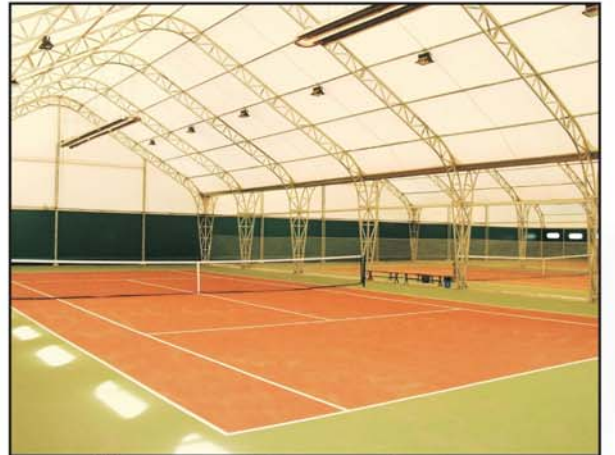
Tenis Kortu Uygulaması: U Tip Üniter Sistem-Lokal Isıtma
