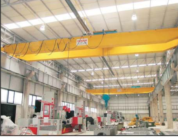
Fabrika Uygulaması: Düz Tip Çok Yakıclı Sistem-Genel Isıtma
