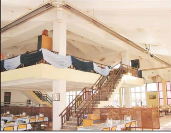
Restaurant Uygulaması: Düz Tip Üniter Sistem-Genel Isıtma
